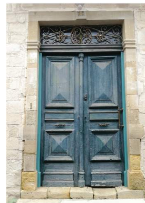
Με μεταλλικά στοιχεία και υαλοπίνακα
